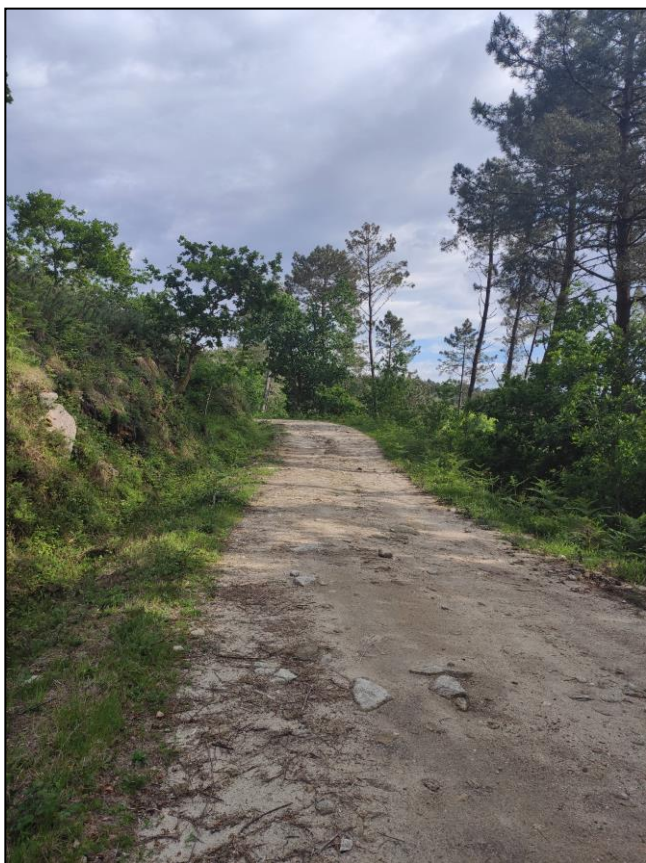
Fotografía nº 11: traballos realizados nas faixas auxiliares de pista
