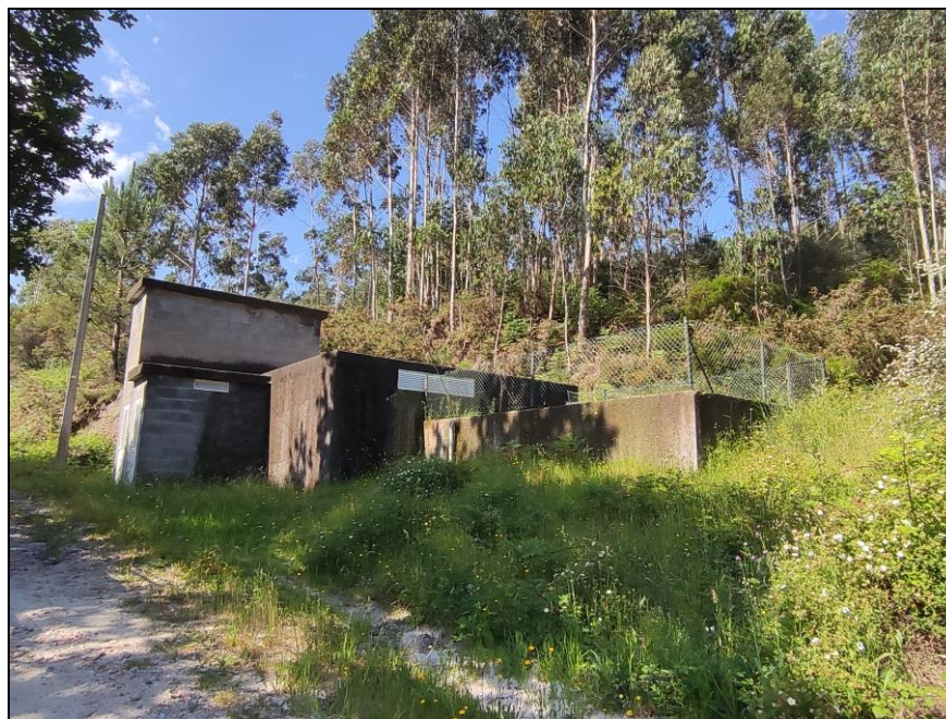
Fotografía nº23: Depósito A Portela sen reformar
