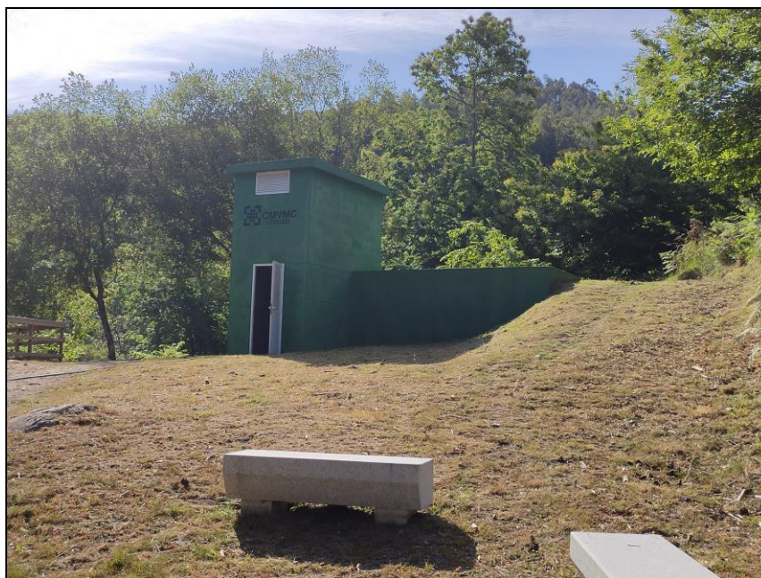
Fotografía nº 12: Deposito de Pisqueiras reformado
